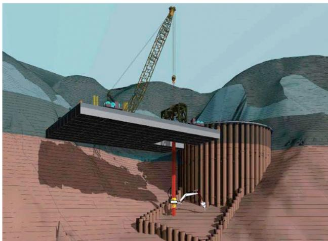
日本は、1時間当たりの最大雨量が年々増大している。数十年前に作ったダムは軒並み、改良工事が必要になってきている。しかしダムの湖底は急傾斜で水深があり、水中バックホウを停止できない。そこで、船の上からシャフトを下ろしてシャフト先端を地盤に固定し、シャフトに沿ってバックホウが降りて掘削していくというしくみを考案した。
